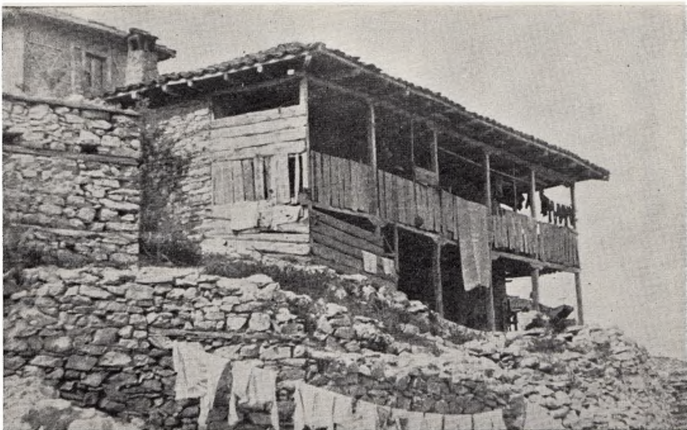
Сл. 24 — Сеоска кућа на спрат; приземље има трем, на спрату је отворен чардак (Македонија)
