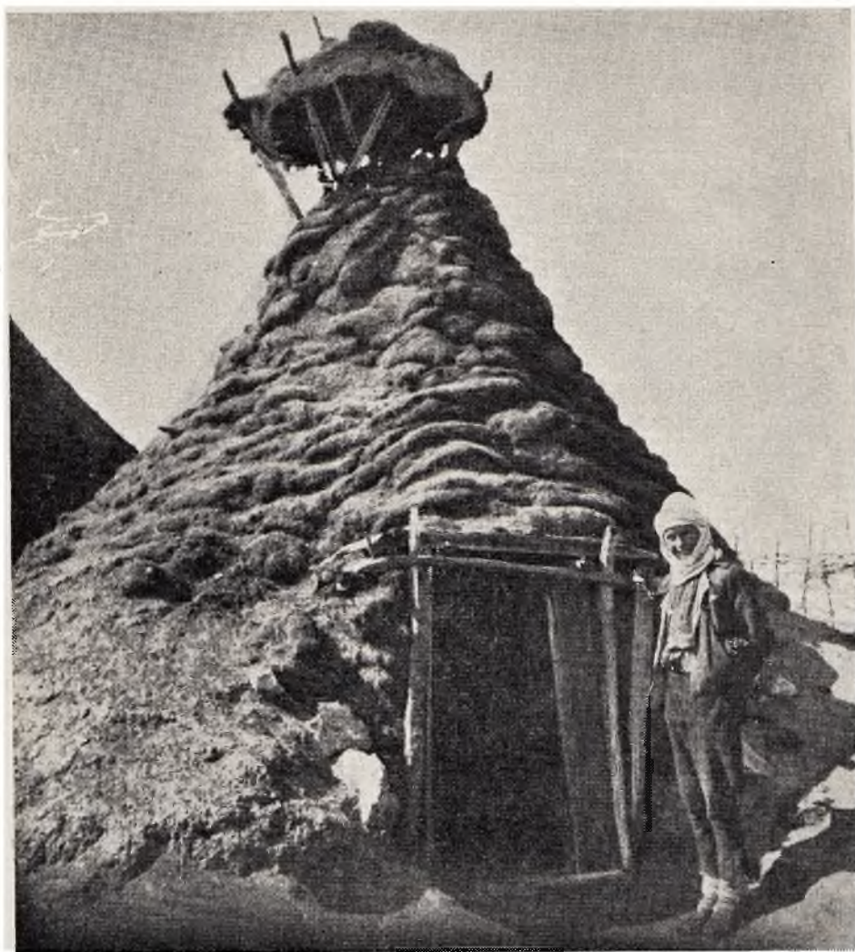
Сл. 4 — Бусара, купа танких стабала покривена бусеном; озго је отвор за дим
