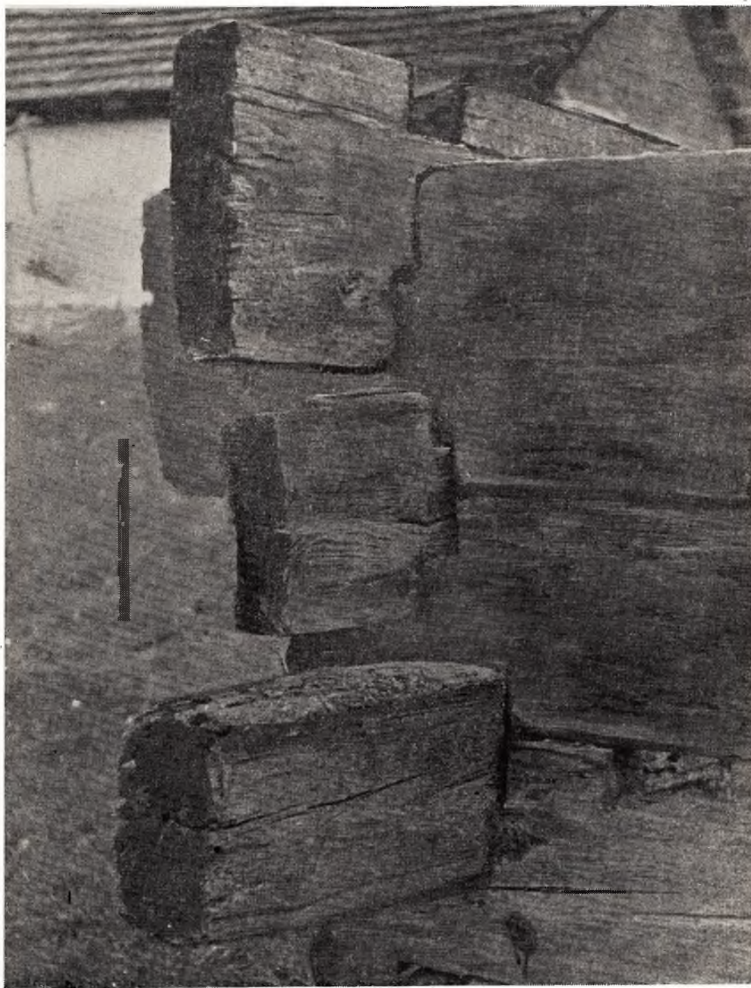
Сл. 8 — Веза брвна на углу зграде брвнаре у т.зв. „усек” или „ћерт” (брвна су засечена озго и оздо за по \frac{1}{4} висине)
