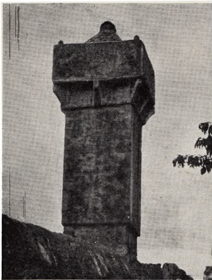
Сл. 87 — Глава димњака, са заклоном противу ветра
