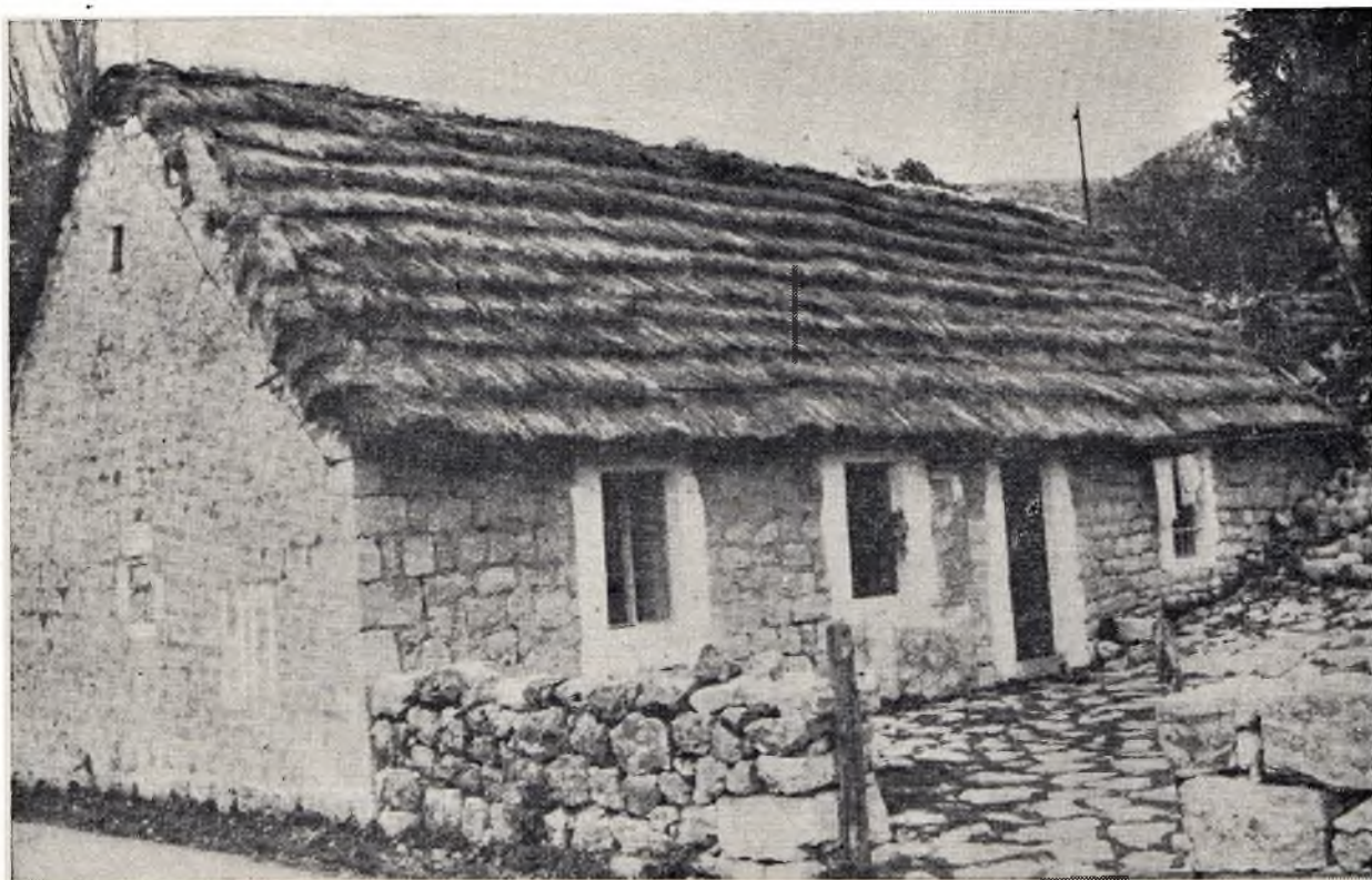
Сл. 30 — Камена приземна кућа у Црној Гори; кров (двосливан) покривен је сламом
