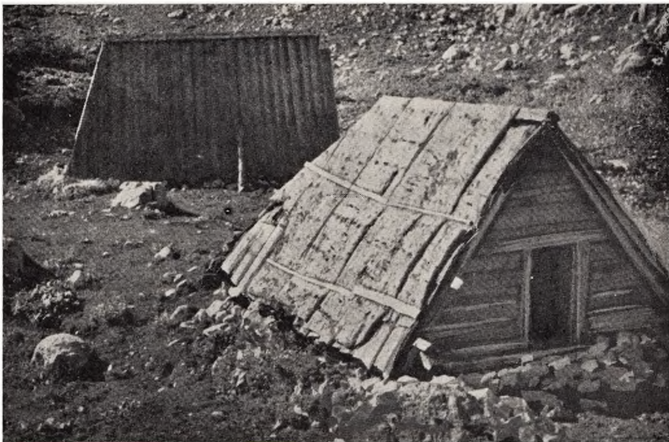
Сл. 5 — Колибе покривене кором огуљеном са стабала дрвета
