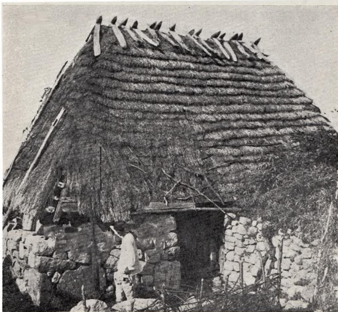
Сл. 7 — Кров покривен сламом, учвршћеном за водоравне летве; сламе је нарочито осигурано да ветар не би развео сламу (Црна Гора)
