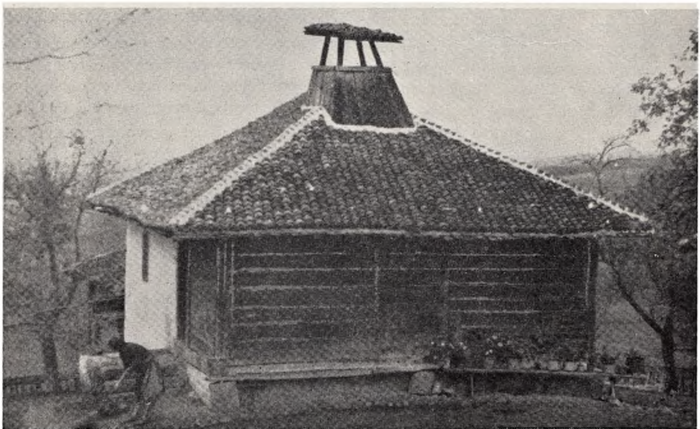
Сл. 15 — Сеоска пола брвнара пола бондручара, покривена ћерамидом (Србија)
