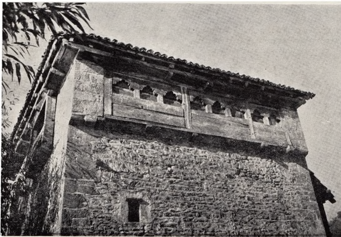
Сл. 39 — Кула; на спрату је дрвена галерија која се може и затворити
