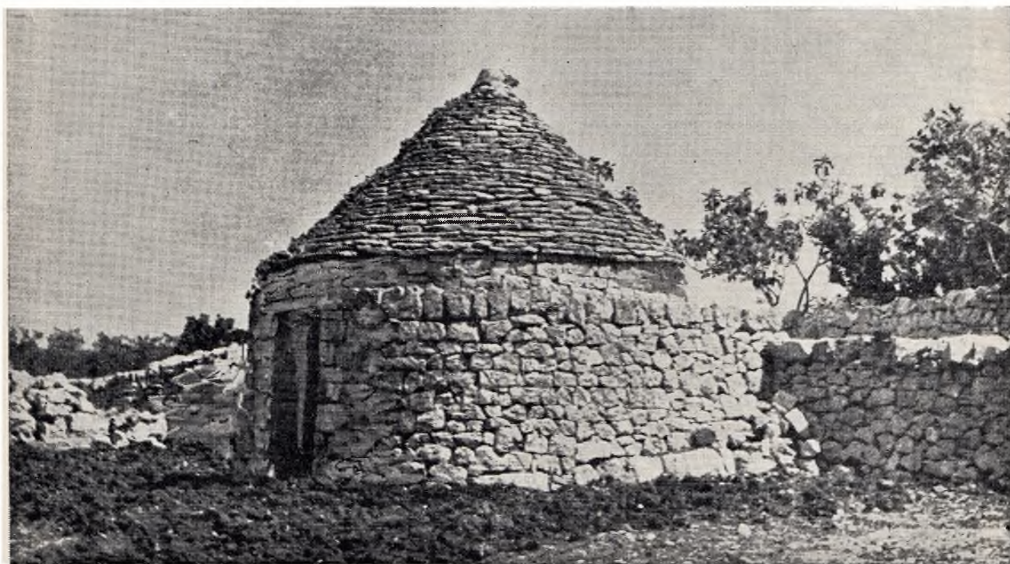
Сл. 3 — Буња у Далмацији. Плочасто камење сложено у купу, са консоластим испуштањем, без засвођавања
