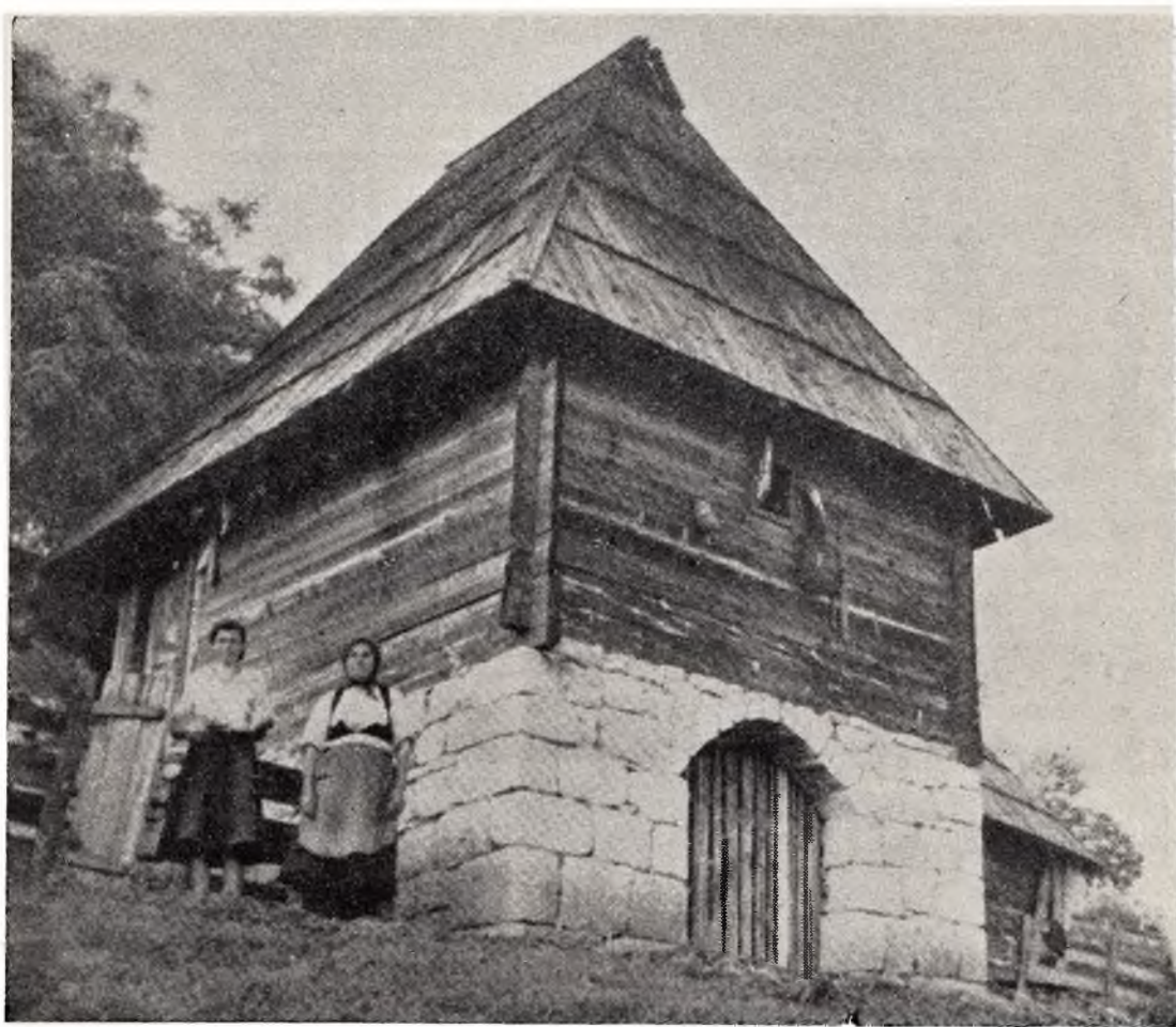
Сл. 11 — Брвнара на озиданом подруму покривена кровом од шиндре (Србија)
