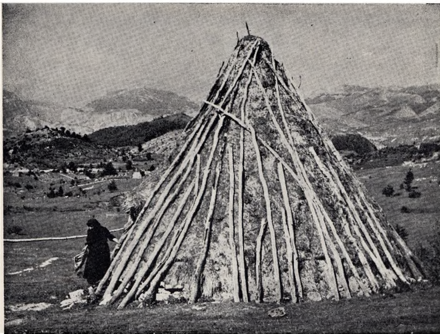
Сл. 2 — Шиља, дубирог, савардак (купа стабала покривена сламом која је озго још притиснута танким стаблима како је ветар не би развео)
