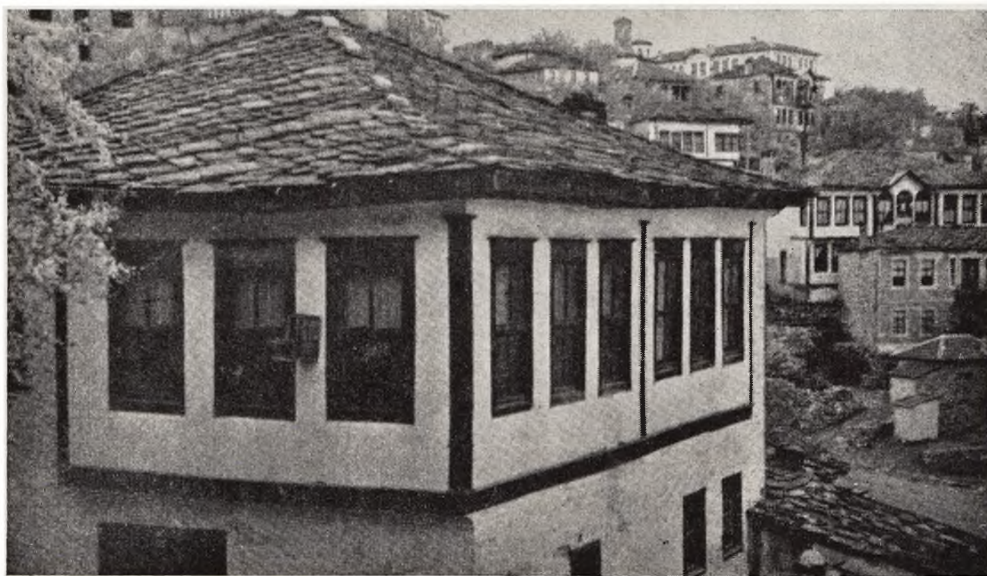
Сл. 69 — Крушево, кров покривен танким каменим плочама
