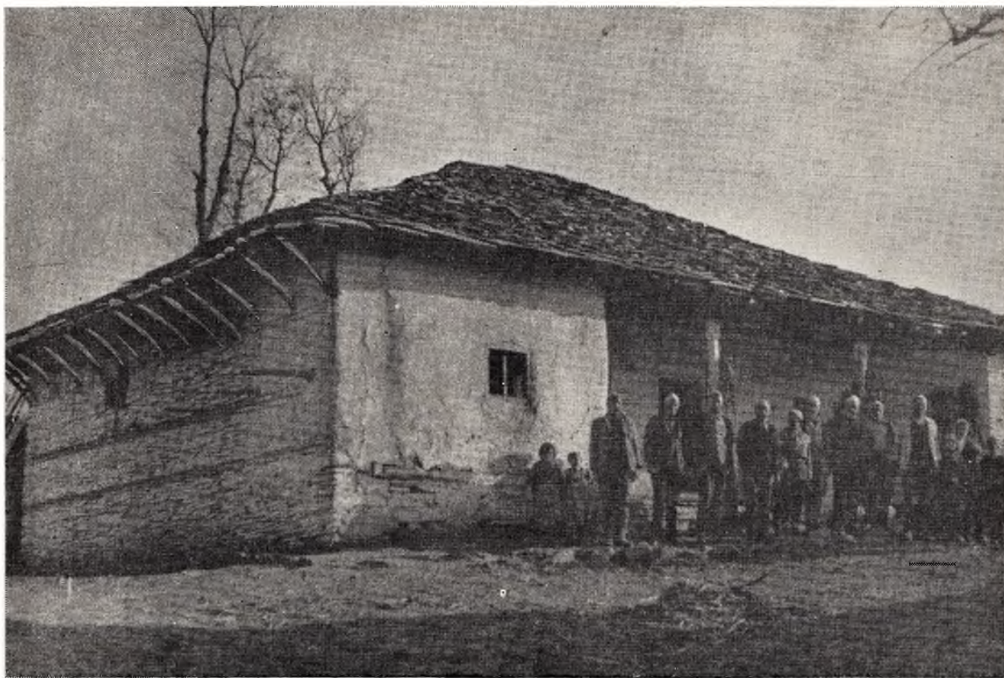
Сл. 23 — Зидови куће су од плочастог камена ојачани водоравним гредицама (Метохија).
