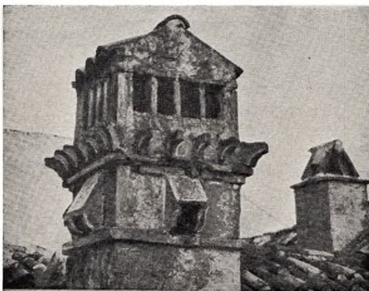
Сл. 88 — Заклон противу ветра је отпао
